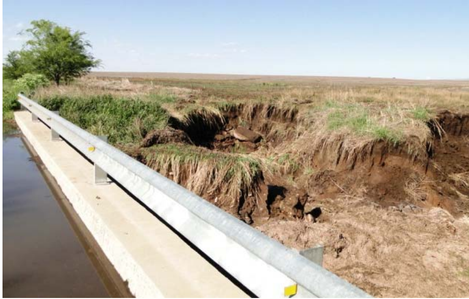
Figura N° 10: Ruta Pcial 23. Puente arroyo La Colacha tributario del arroyo Santa Catalina. Foto 2/11/12
